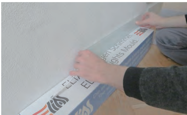
Abb. 5: Anbringen der Heizelemente
