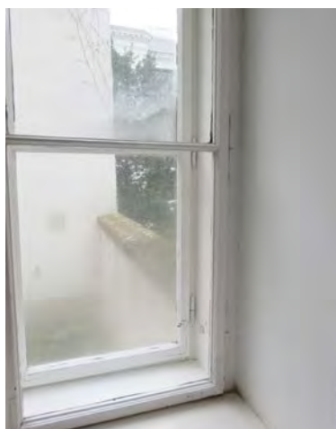
Abb. 2: Kondensatbildung an den Scheiben als Indiz für hohe Raumluftfeuchte
